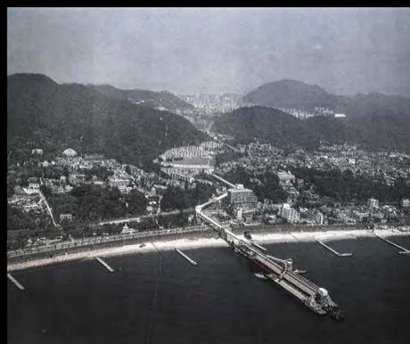
上空より 町の隙間を抜けるようにベルトコンベアが走る
